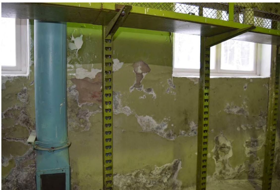
Фото 8. Разрушение отделки стен в осях 1/А-В.
