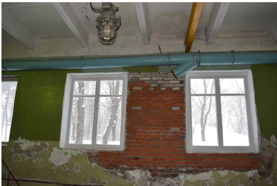
Фото 5. Выполнена перекладка стены в осях 1/А-В.
