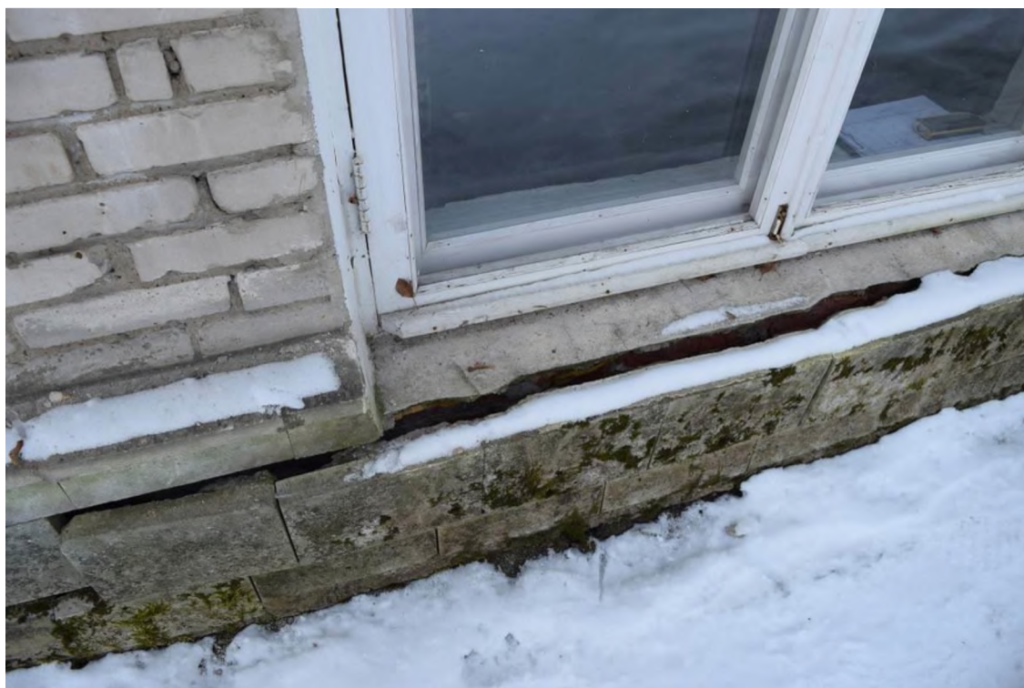
Фото 19. Разрушение цоколя в результате намокания.
