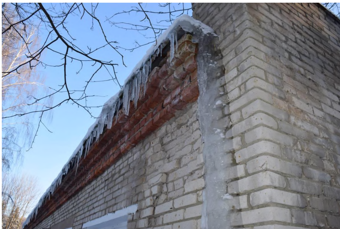
Фото 17. Водосток с кровли не организован, в результате чего стены подвергаются намоканию и разрушению.
