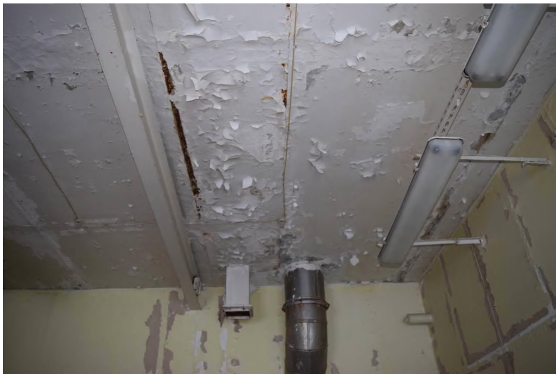
Фото 21. Разрушение отделки второго этажа.
