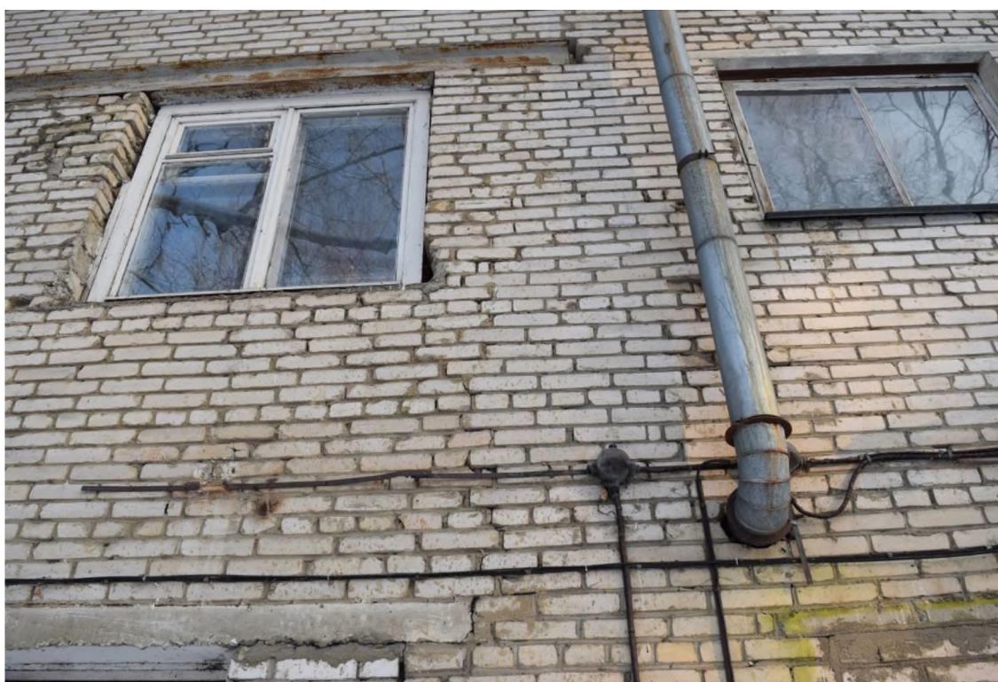
Фото 16. Трещина в наружной стене в осях 3-4/А.
