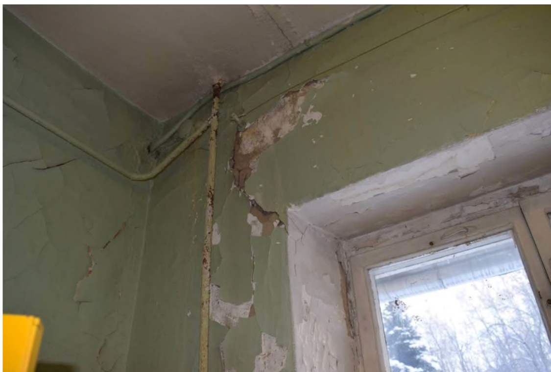
Фото 22. Трещина в наружной стене в осях 3-4/А.
