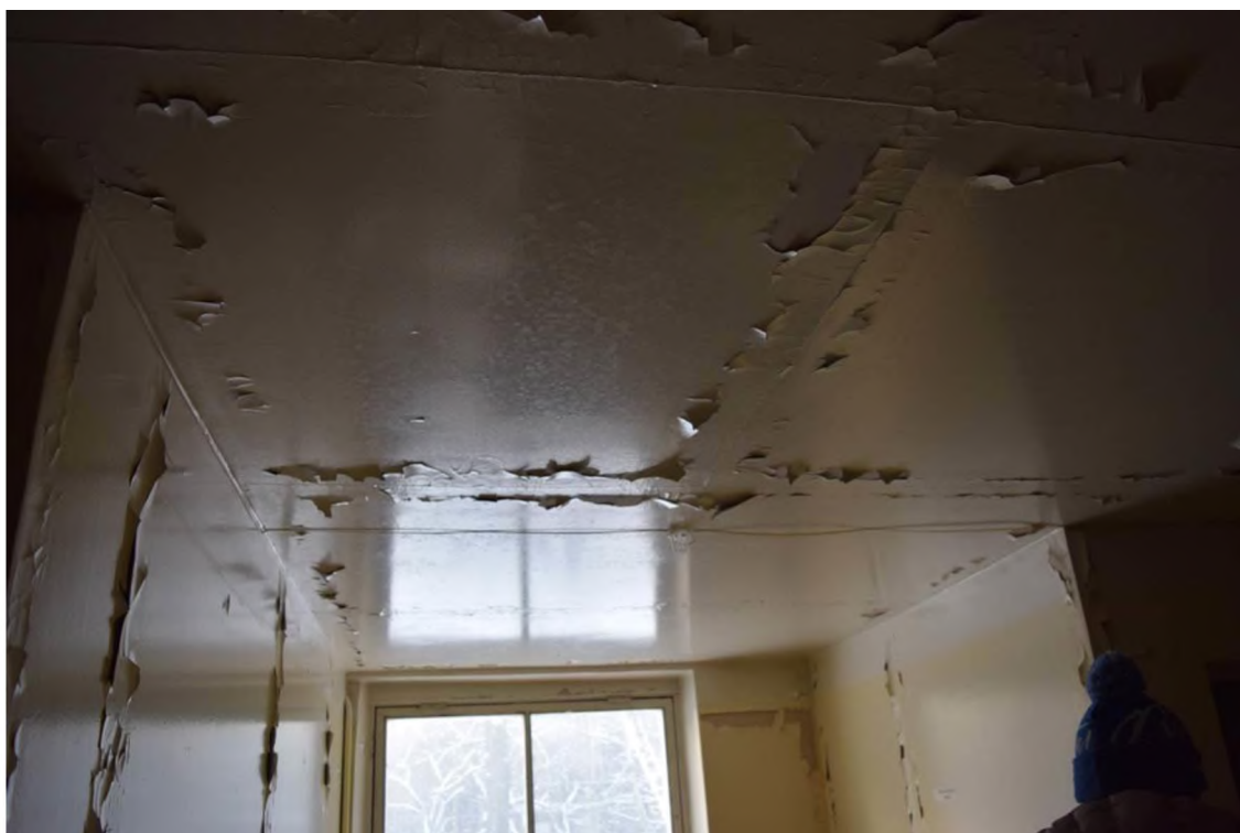
Фото 20. Разрушение отделки второго этажа.
