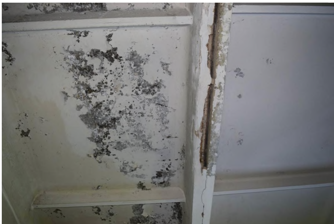
Фото 13. Разрушение плит покрытия. Оголение и корродированные защитного слоя бетона арматуры.
