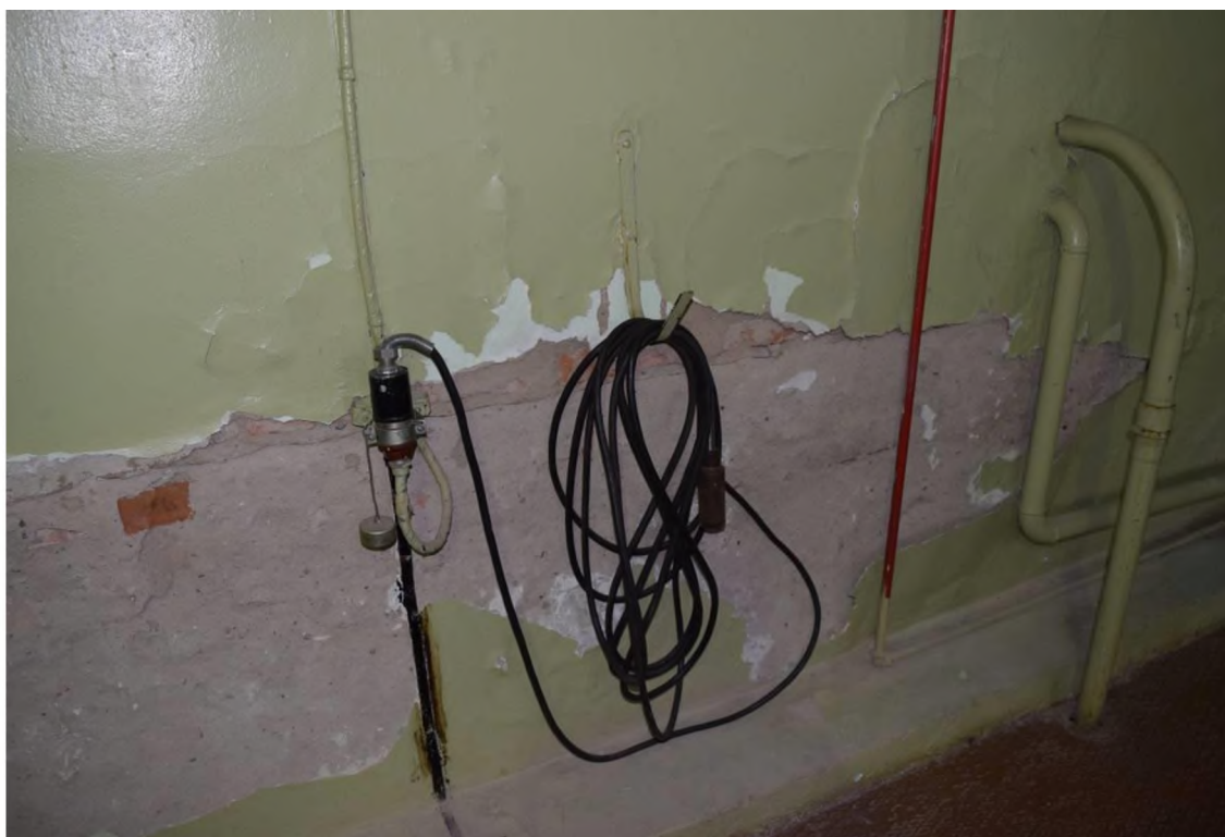
Фото 6. Разрушение отделки стен в осях 2/А-В.
