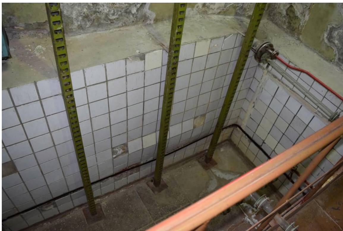
Фото 7. Разрушение отделки стен в осях 1/А-В.
