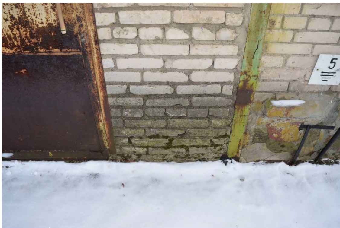
Фото 14. Разрушение цоколя.
