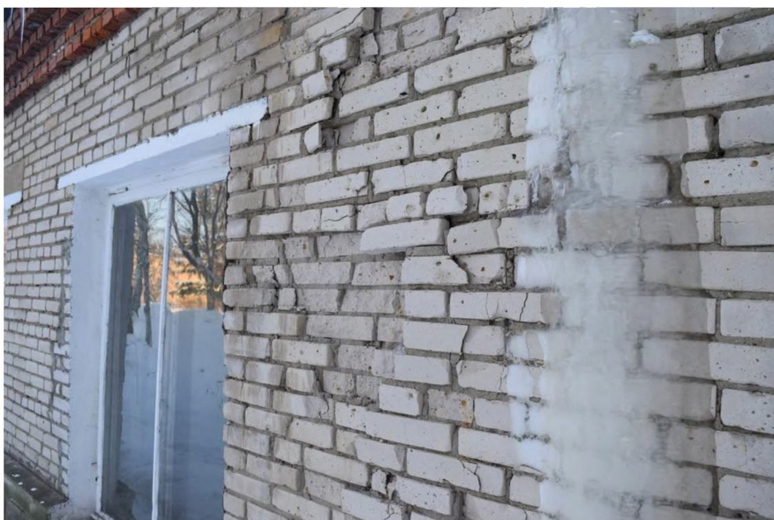
Фото 18. В результате намокания стены происходит разрушение кладки.
