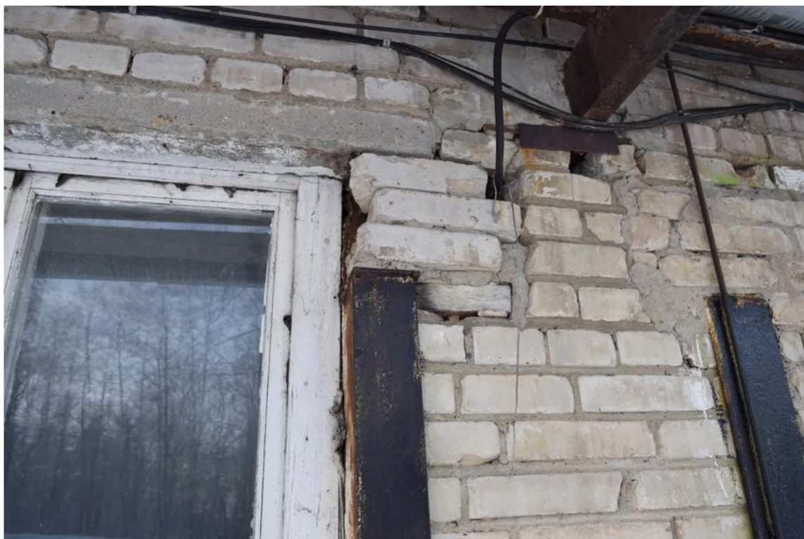
Фото 24. Выпадение отдельных камней кладки.
