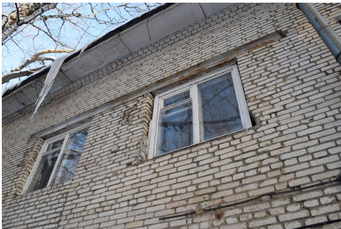
Фото 15. Разрушение кладки стены с выпадением отдельных камней.
